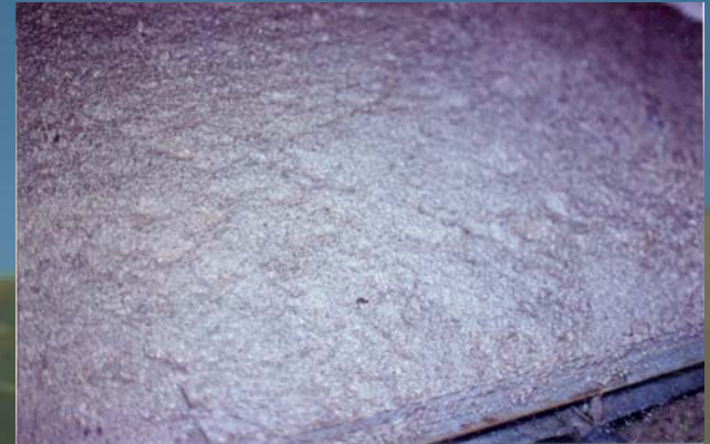
Foto 22: Formaciones sobre el material por efecto del escurrimiento
